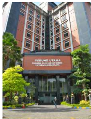
Gambar. Gedung Perkuliahan
